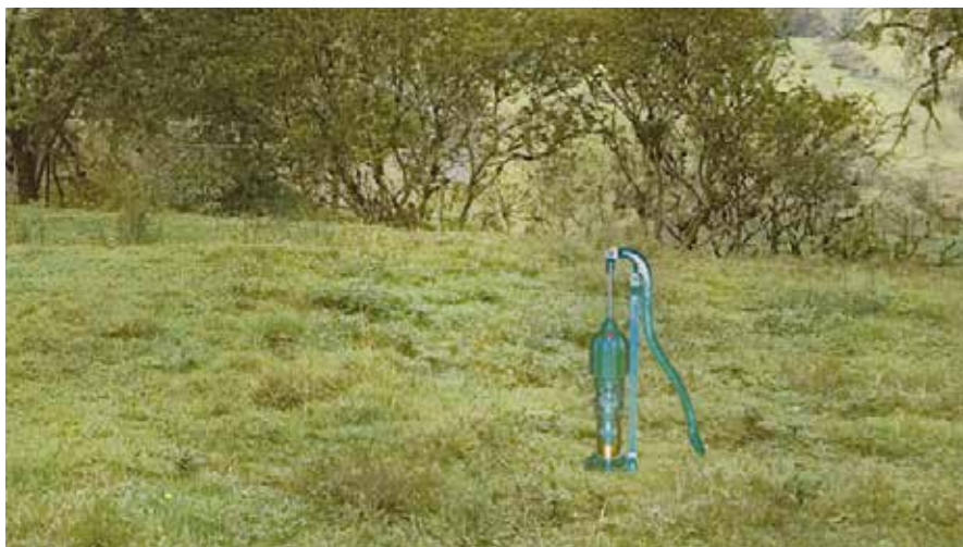
Figura 32. Toma de agua subterránea.
