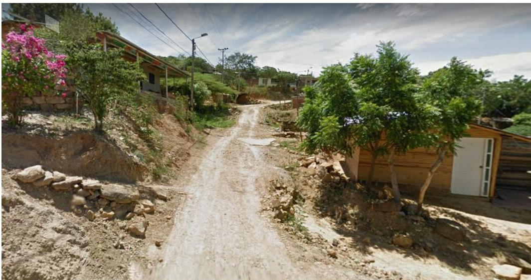
Figura 18. Barrio el Progreso Vías en mal estado
