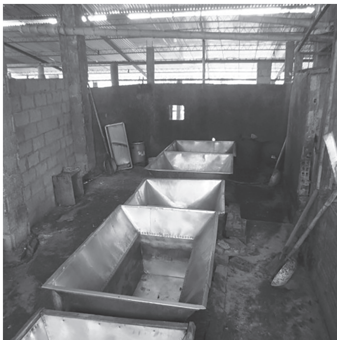
📍 Figura 27. Instalaciones locativas en entable panelero, zona de calderas
