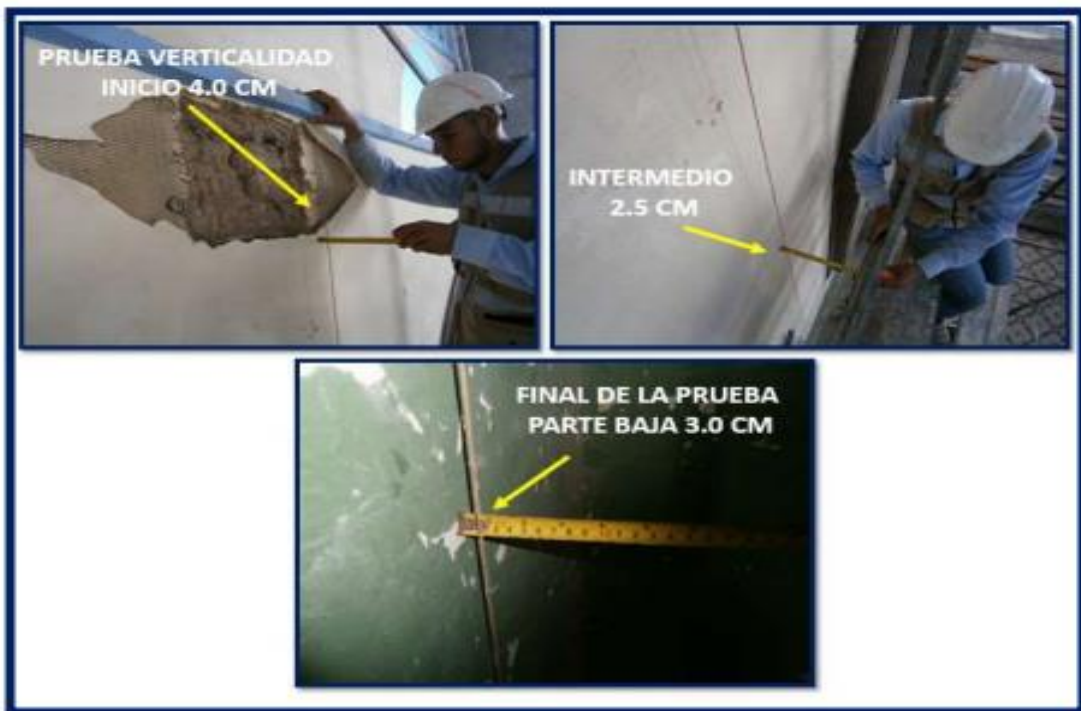
Ilustración 68. Prueba de verticalidad muros Fuente: Edycons S.A.S, 2018
