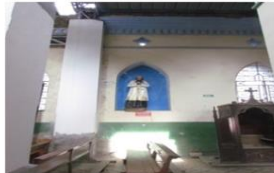
MURO COSTADO ESTE INTERIOR- EJE A - CARACTERÍSTICAS DE LOS MATERIALES Y ESTADO
