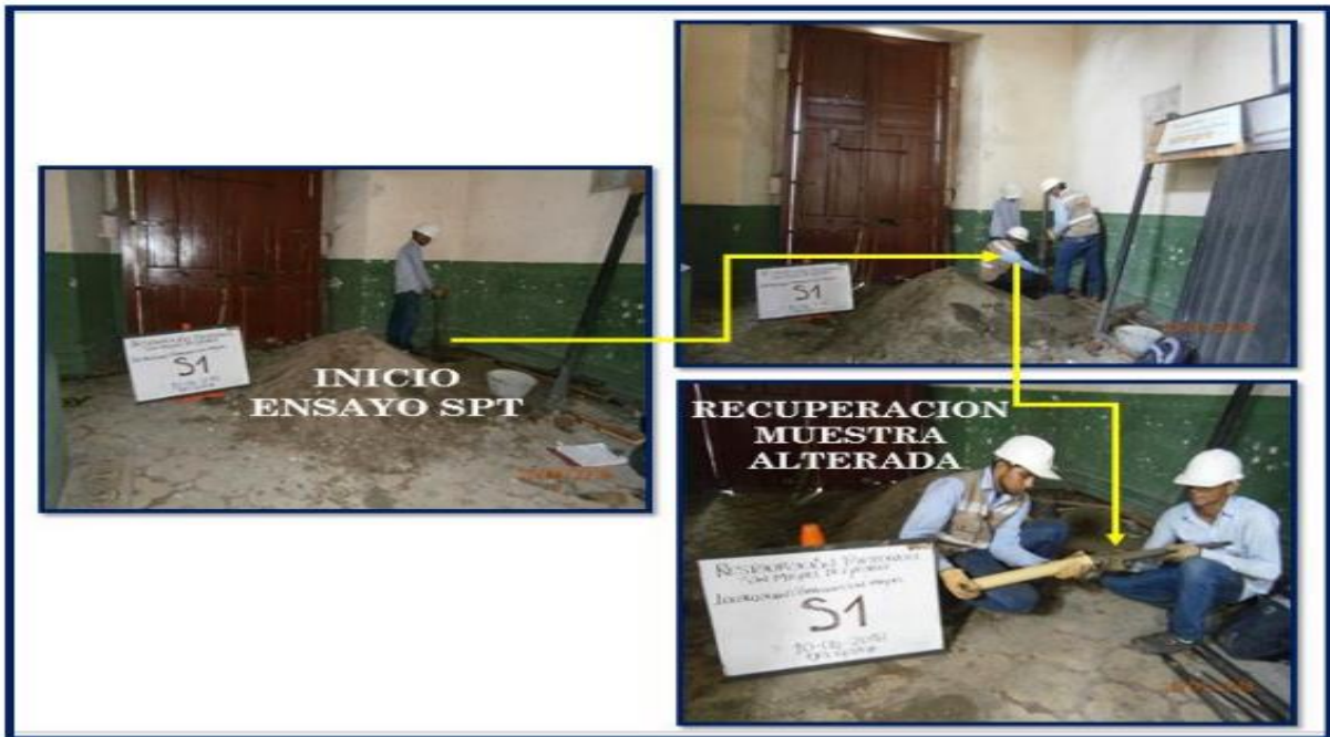
Ilustración 70. Ensayo de Standard Penetration Test – SPT Fuente: Edycons S.A.S, 2018
