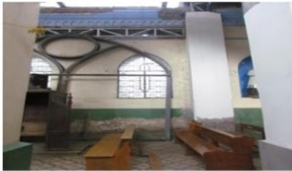
MURO COSTADO ESTE INTERIOR- EJE A - CARACTERÍSTICAS DE LOS MATERIALES Y ESTADO
