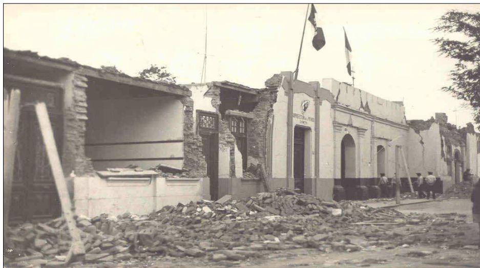
Ilustración 11. Colapso lateral a partir del alféizar de la ventana
