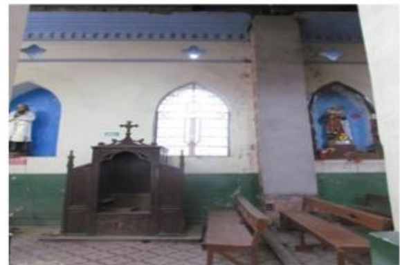
MURO COSTADO ESTE INTERIOR- EJE A - CARACTERÍSTICAS DE LOS MATERIALES Y ESTADO
