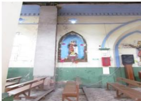
MURO COSTADO ESTE INTERIOR- EJE A - CARACTERÍSTICAS DE LOS MATERIALES Y ESTADO
