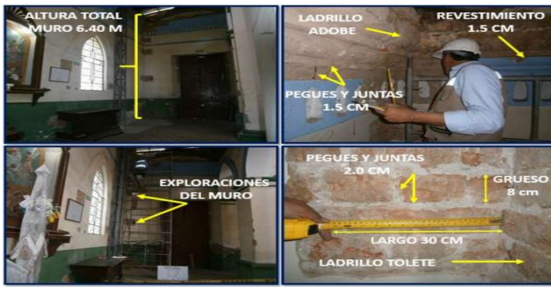
Ilustración 63. Estudio de materiales, exploraciones de Muros Fuente: Edycons S.A.S, 2018
