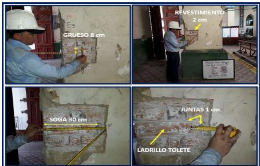
Ilustración 64. Exploración de columnas Fuente: Edycons S.A.S, 2018
