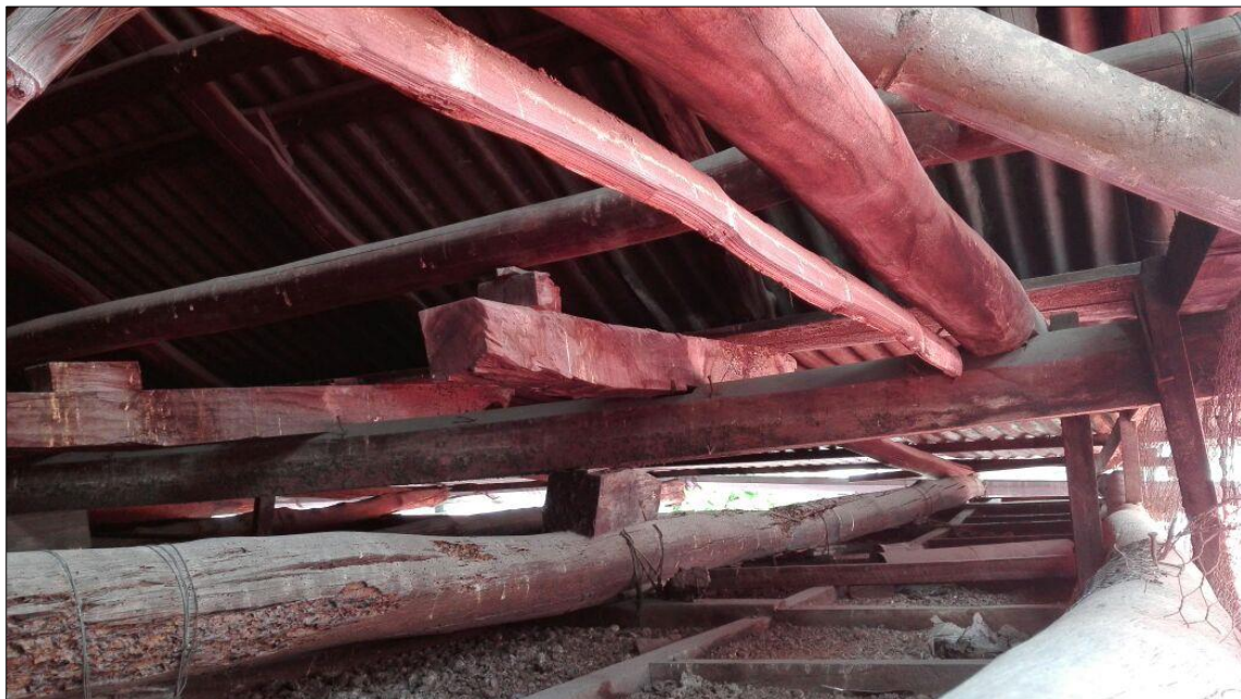
Ilustración 55. Interior de cubierta antigua Parroquia San Miguel Fuente: Elaboración propia, 2017.
