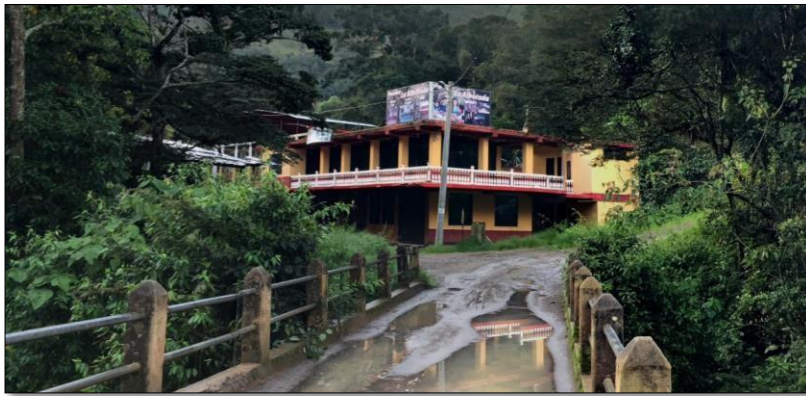
Figura 4. Ejemplo de vivienda en la zona
