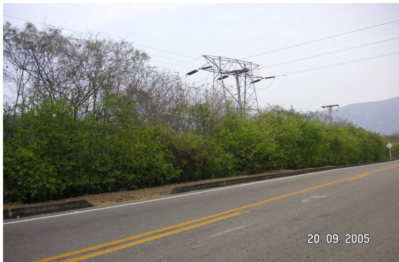
Figura 13: Aspecto de la pantalla visual construida desde hace varios años sobre la carretera Apulo – Bogotá
