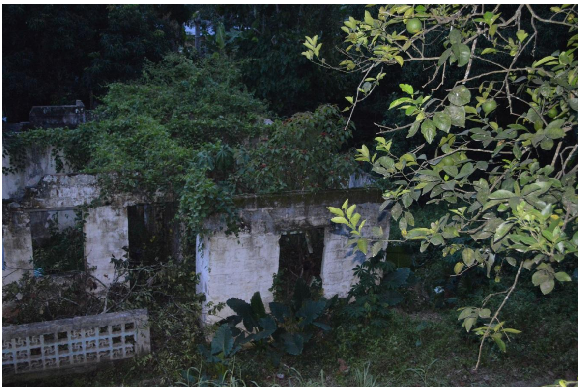
Virginias corregimiento de Puerto Berrio Antioquia, vivienda abandonada, Yuliana Arias, Abril de 2015. Fotomontaje digital. Archivo de la autora.
