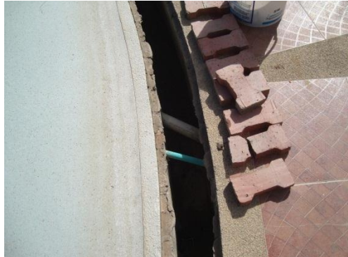
Fotografía: canaleta perimetral existente ( Piscina Alto Magdalena) (24/07/2013)
