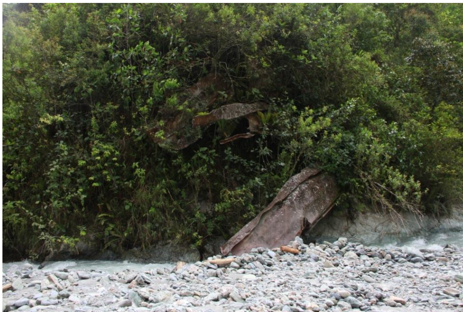
Antiguo puente de Quebradablanca destruido por el alud de tierra- foto por Geraldine Laura A.Taborda Dávila
