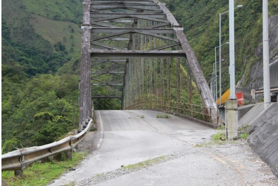
Antiguo puente de Quebradablanca, fue construido después de la tragedia- foto por William Mendoza Donado
