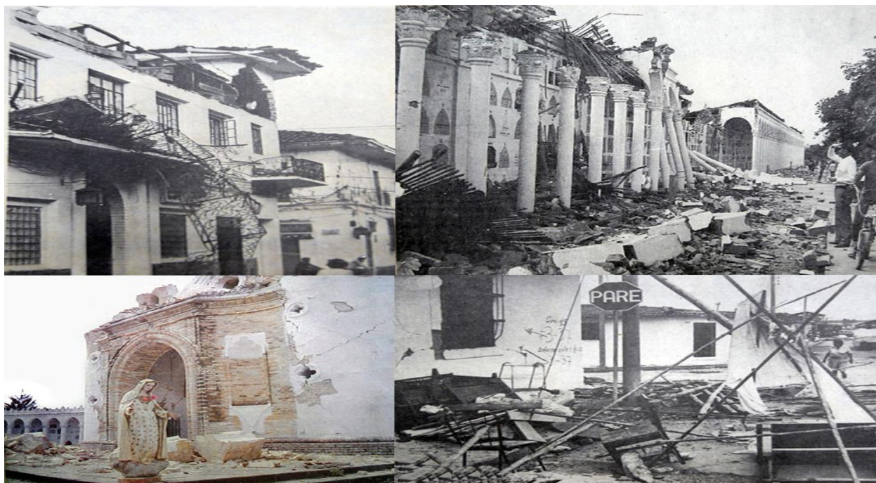
Foto 5 Edificaciones coloniales sin normas sismo resistentes / Fuente: El País
