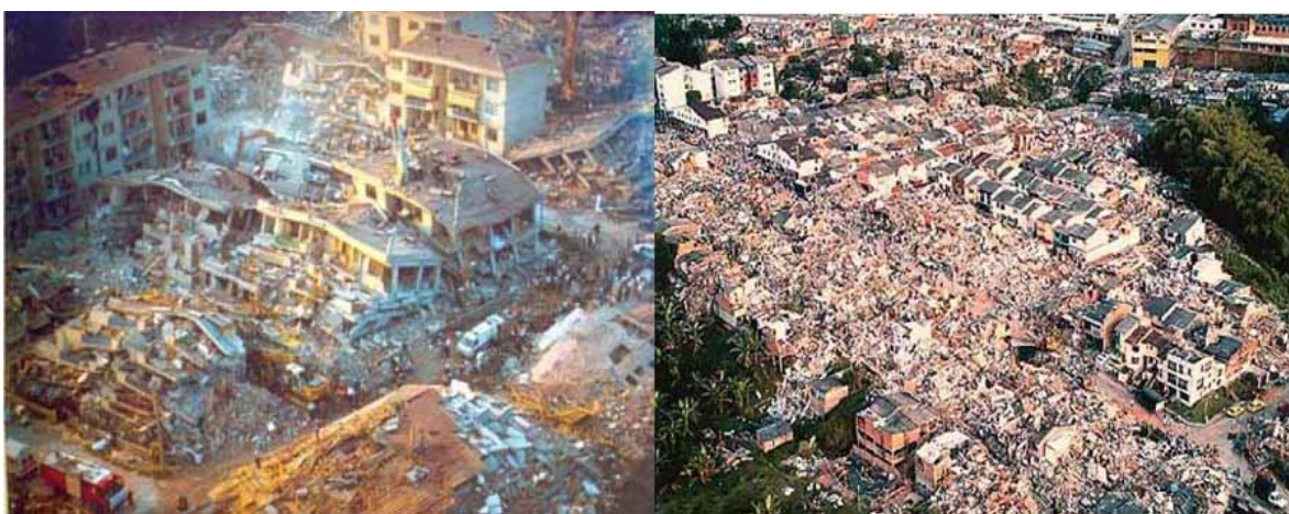
Foto 6 Zona destruida en la ciudad de Armenia por el terremoto de 6,2 grados / Fuente: 20minutos
