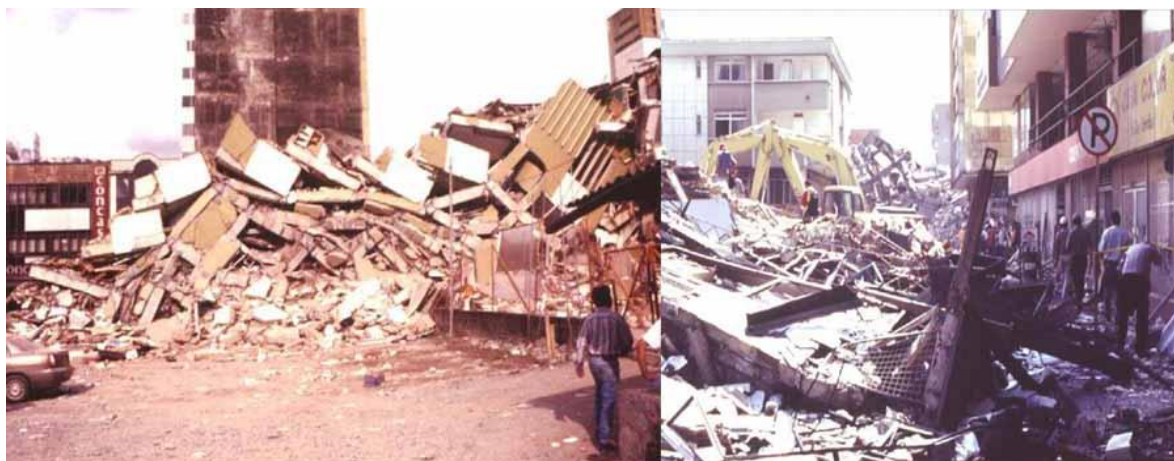
Foto 7 Edificaciones hechas en concreto colapsaron ante el movimiento telúrico / Fuente: Universidad Nacional
