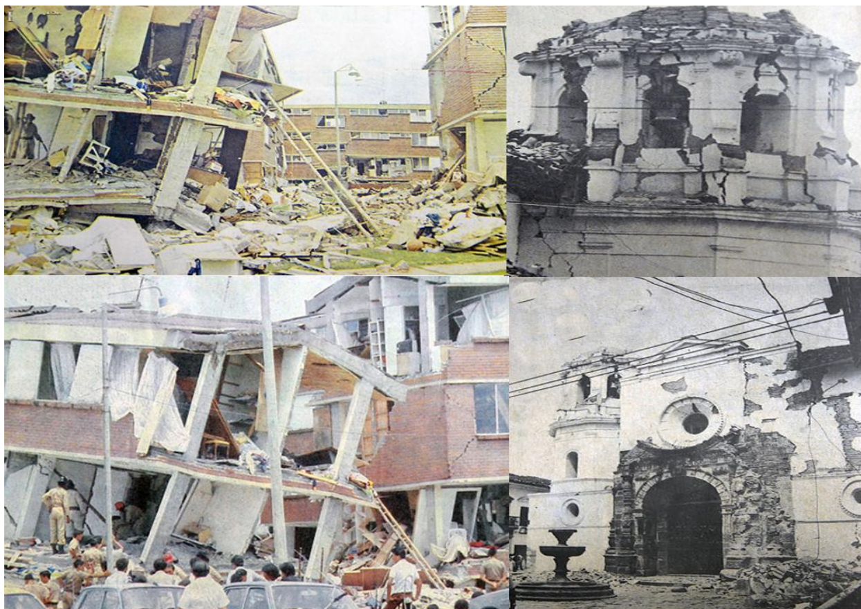
Foto 4 Torres de apartamentos se vinieron al suelo / Fuente : El Pais
