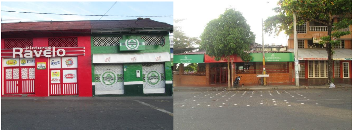
Figura 13. Reductores de velocidad sobre las carreras décima y novena. Fuente propia.
