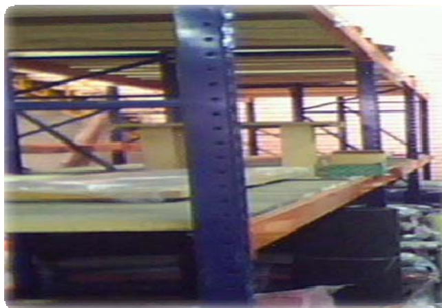
Fig.16 Reestructuración general de la bodega materia prima (inactiva).
