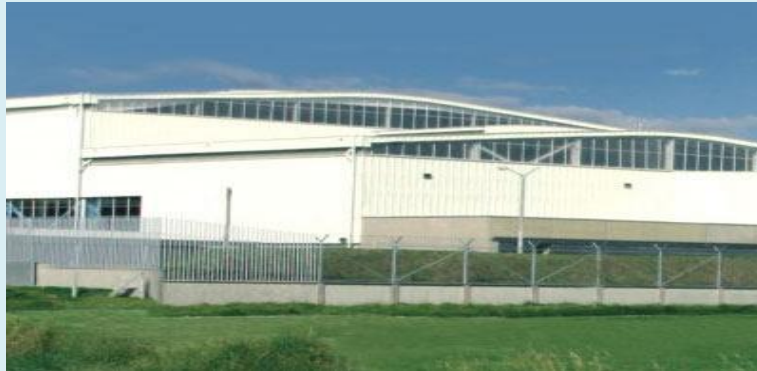
Figura 2: fotografía planta pvc Gerfor Cota
