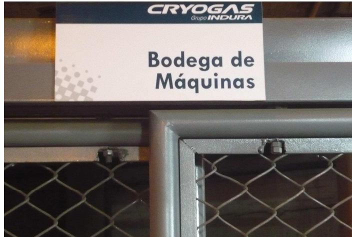
Figura 10c Identificación de las zonas (Bodega de maquinas)
