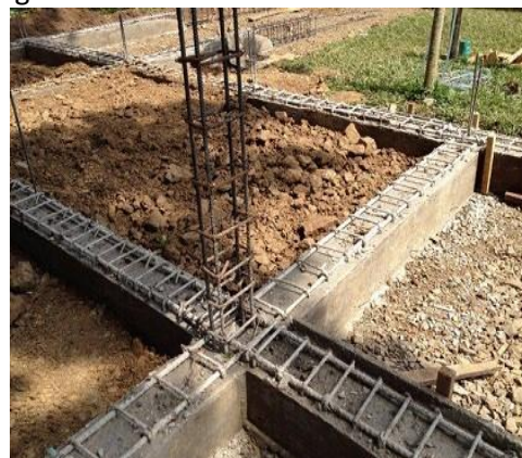
Figura 84 Vigas de cimentación
