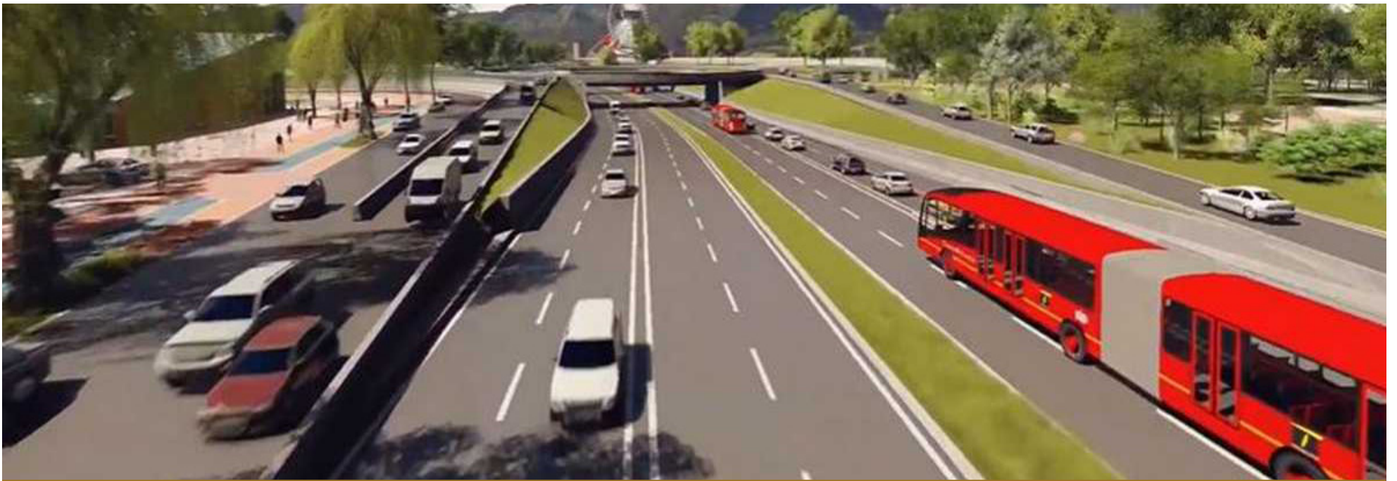
Así será la troncal de TransMilenio por la Avenida 68; ya iniciaron obras de construcción - Foto: Alcaldía de Bogotá
