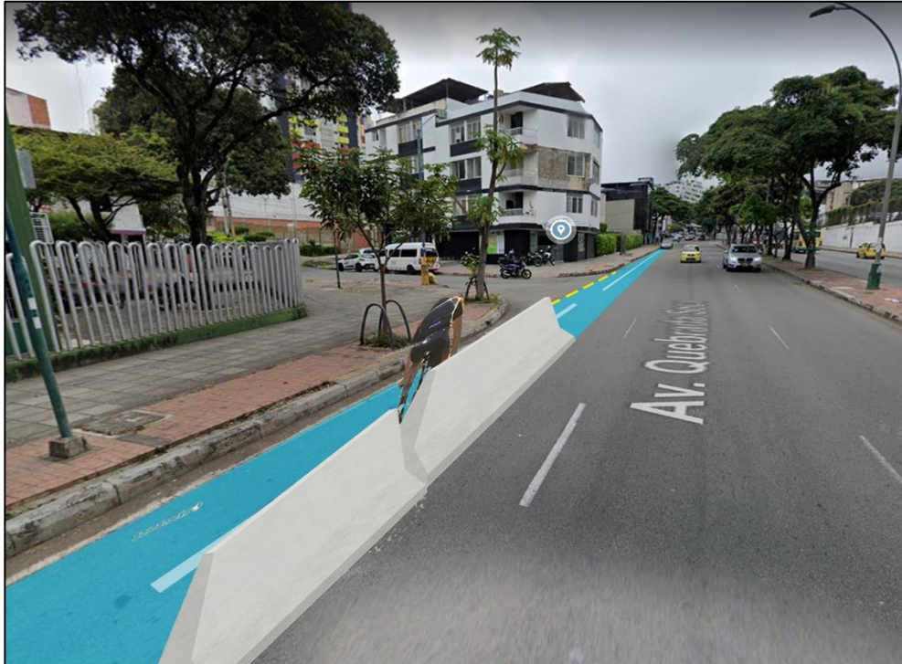
Implementación de elementos de protección en concreto tipo muro Jersey
