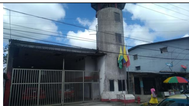
Subestación de Independencia.
