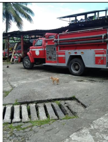
No hay señalizaciones en patio vehicular de subestación de Independencia.
