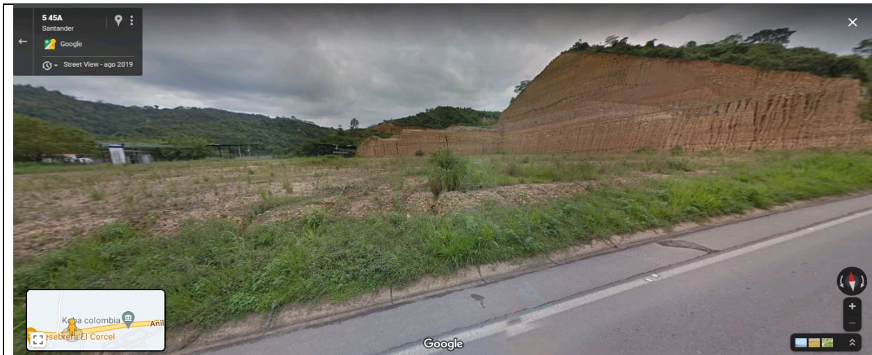
Figura 16. Posible localización planta RCD vista planta. Fuente google maps
