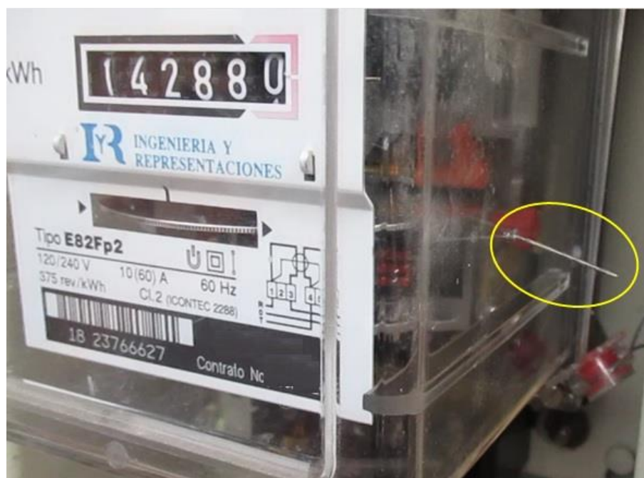
Figura 5. Interrupción del registro de consumo. (Fotografía suministrada por EPM)
