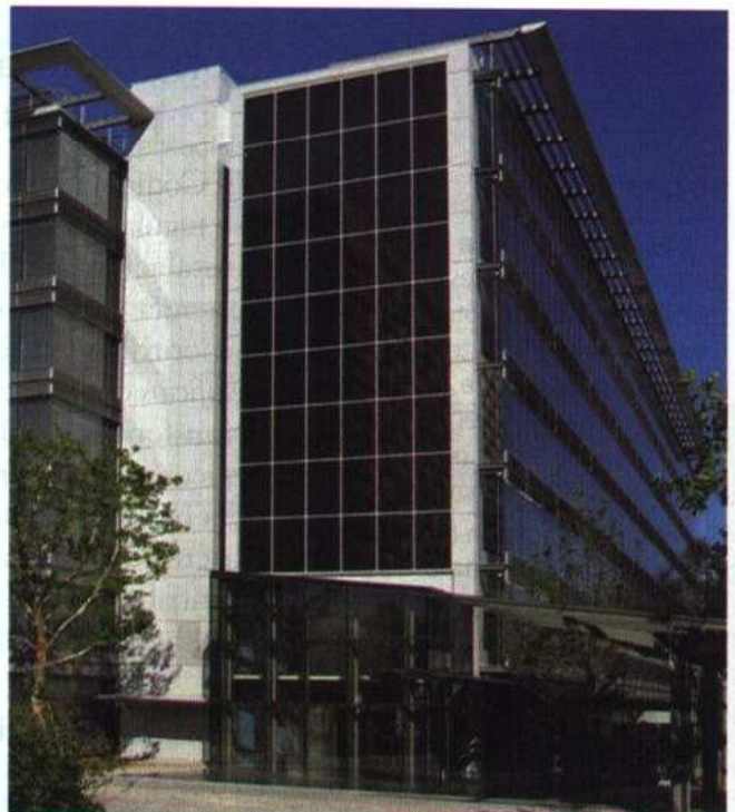
↑ Figura 5.4. Sistema fotovoltaico integrado en una fachada (Schott Solar).
