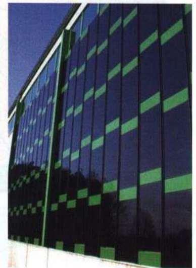
↑ Figura 5.8. Ejemplo de módulos fotovoltaicos integrados en la fachada (Schott Solar).
