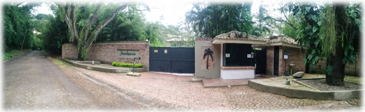
Figure 1- Fachada Condominio Campestre Santuario - propia
