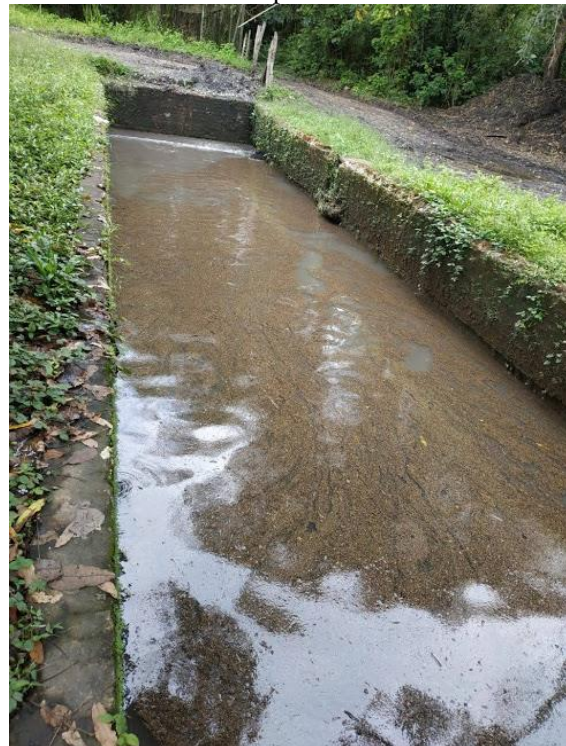
Imagen 399. Vista inferior tanque desarenador municipal. Autor
