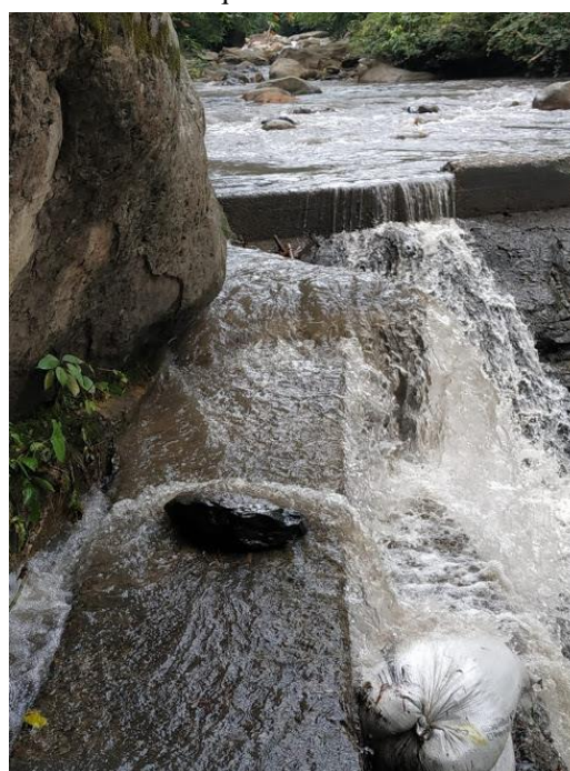
Imagen 327. Inspección visual cámara de quietamiento. Autor
