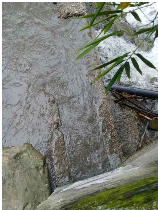
Imagen 318. Bocatoma de fondo actual. Autor
