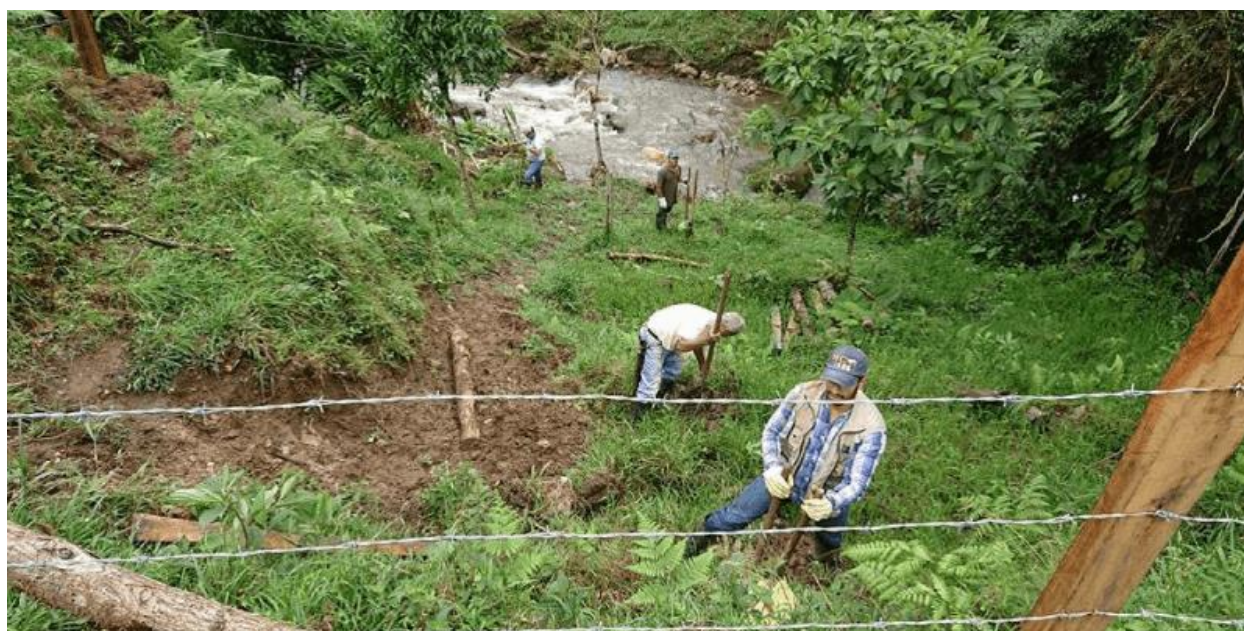
Imagen 480. Trabajos de preservación Quebrada Campos. Adaptado de: Fundación Lazos del Calandaima
