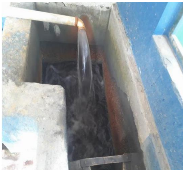
Imagen 461. Adición del coagulante. ( Becerra y Alvarado, 2018 )
