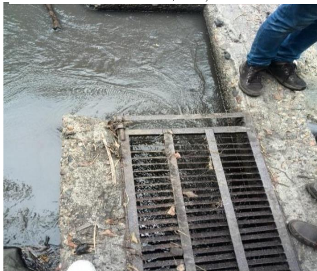
Imagen 291. Rejilla de bocatoma antigua. (Becerra y Alvarado, 2018)
