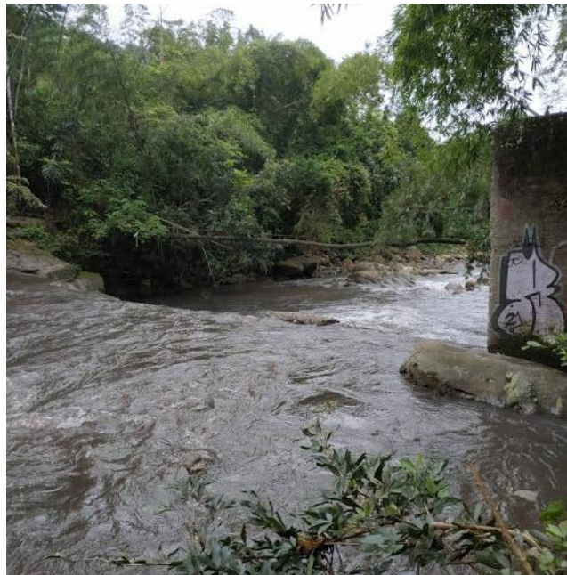
Imagen 282. Bocatoma de rejilla de fondo actual. Autor
