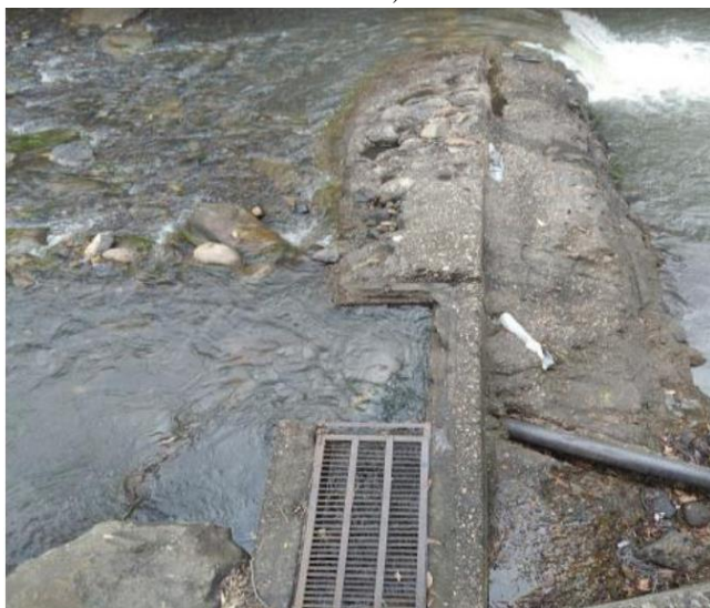
Imagen 300. Bocatoma de fondo antigua. (Becerra y Alvarado, 2018)
