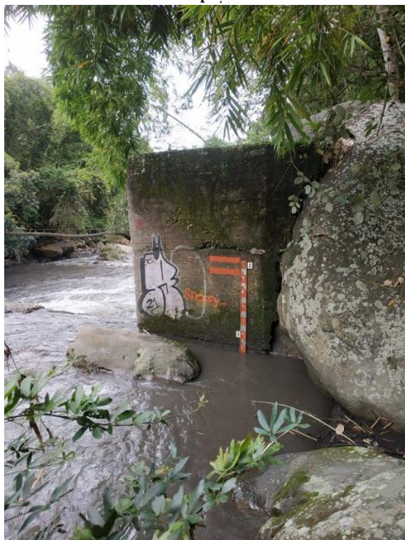
Imagen 228. Parte superior de punto de captación.
