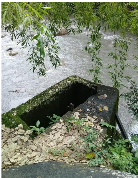
Imagen 264. Vista alta cámara de captación. Autor
