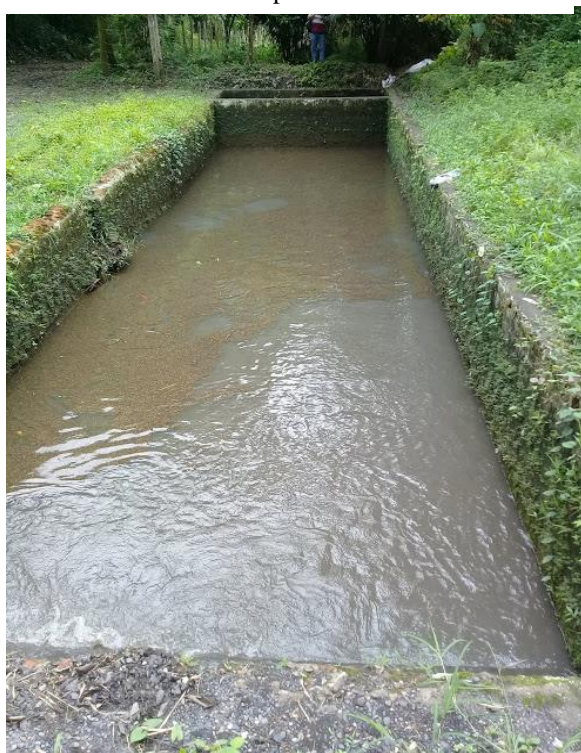
Imagen 408. Tanque desarenador acueducto municipal. Autor
