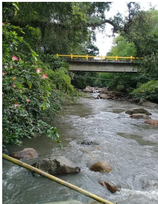
Imagen 210. Vista del puente desde el punto de captación. Autor
