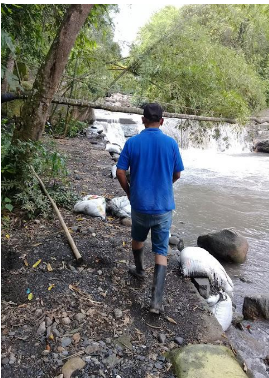
Imagen 363. Operario Ingeagua E.S.P en la zona. Autor
