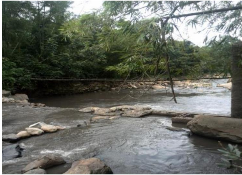
Imagen 273. Bocatoma de rejilla de fondo antigua. (Becerra y Alvarado, 2018)
