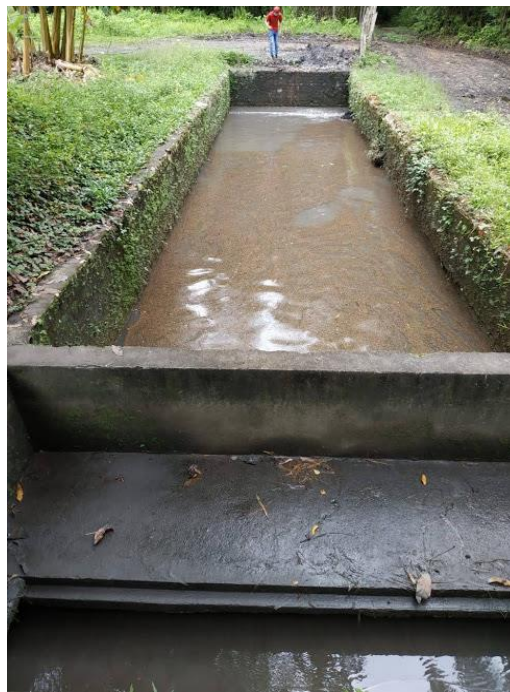
Imagen 426. Vista inferior cámara de separación. Autor
