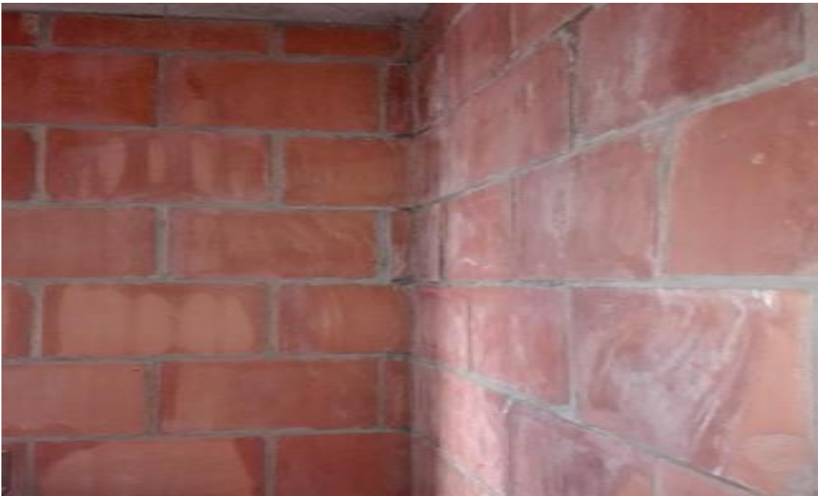
Figura 41. Modelo 2, Mampostería ladrillo a la vista Tomado de: (Miranda & Buitrago Daza, 2018)
