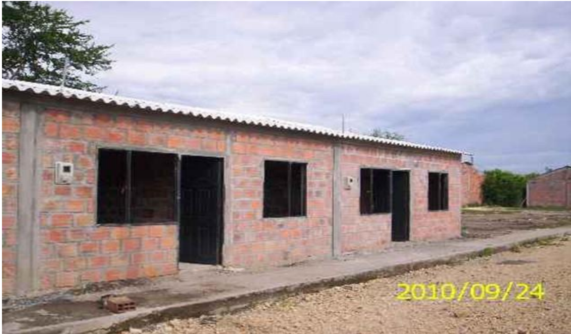
Figura 21. Puertas y ventanas metálicas
