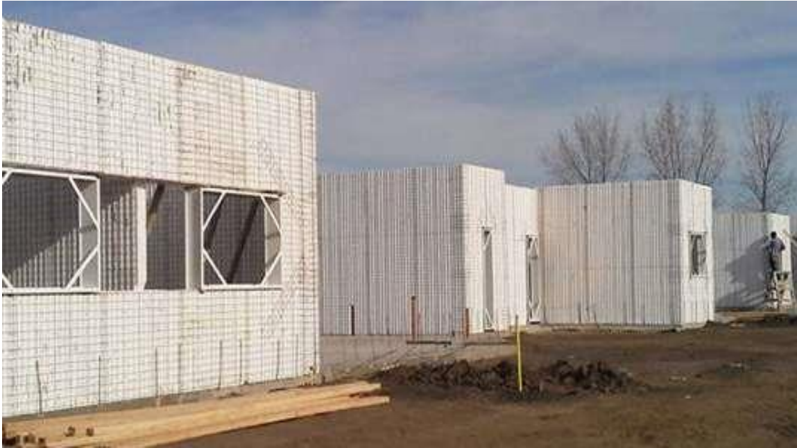
Figura 5. Paneles de EPS con Hormigón proyectado.
