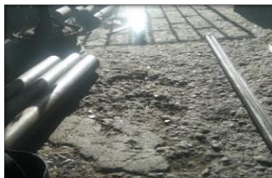
Figura 19. Condiciones del piso y el acceso del pasillo de Fabrintec Ltda.
