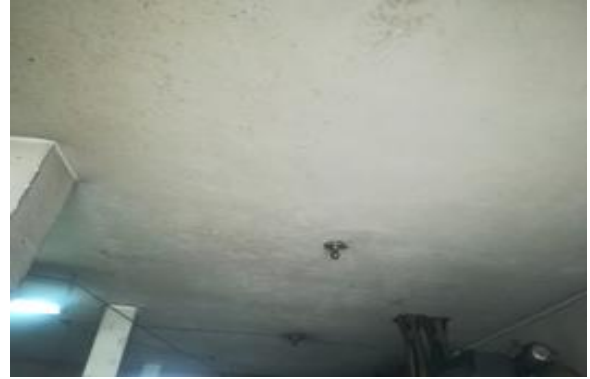
Figura 22. Luminarias averiadas de la Planta de Fabrintec Ltda.
