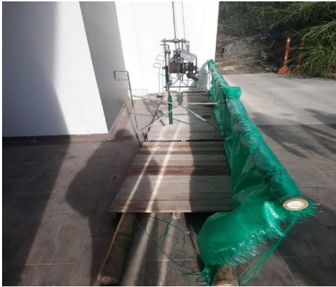
Ilustración 9 andamio en madera
