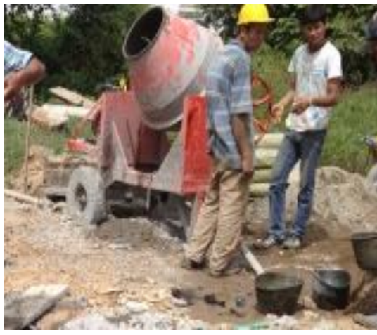
MEZCLADORA DE CONCRETO
