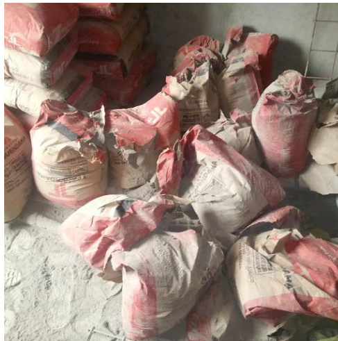
Imagen 11 Almacenamiento de Cemento
