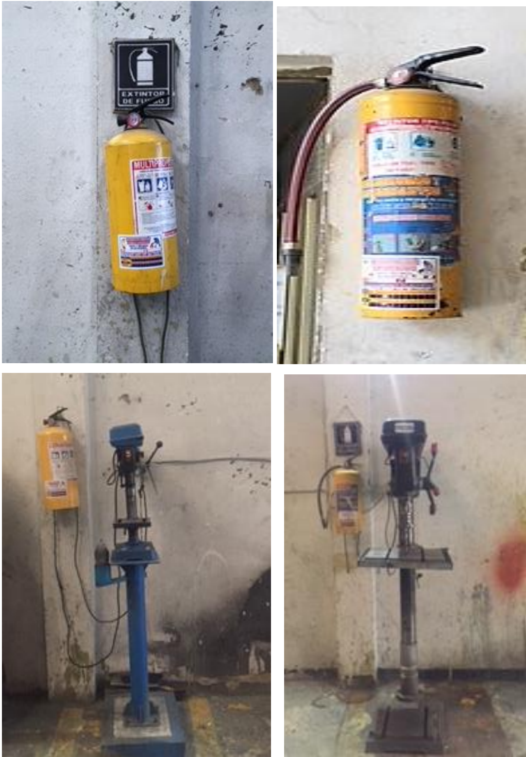
Figura n° 27 entrega e instalación de extintores
