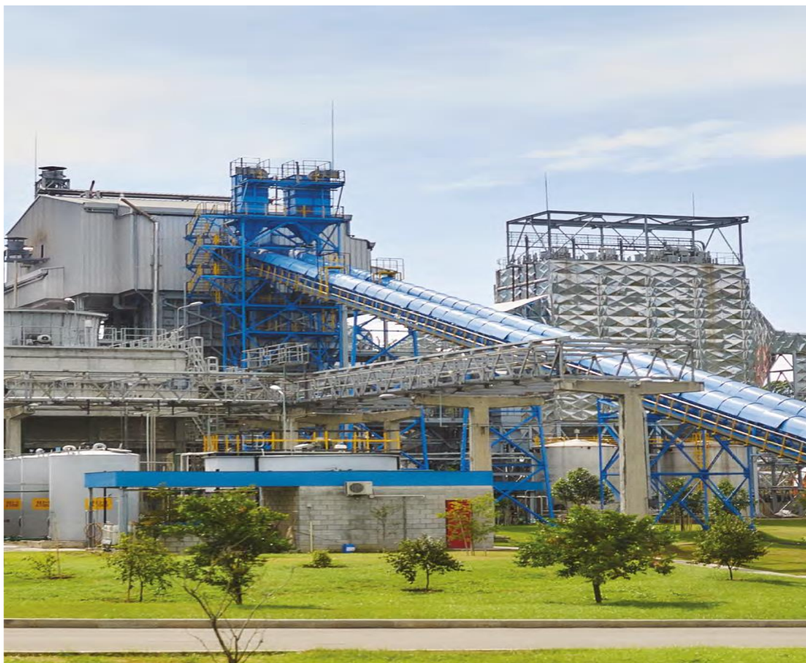
Figura 11. Planta de energía Enka.
