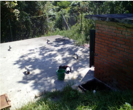
Figura 11. Tanque de almacenamiento
