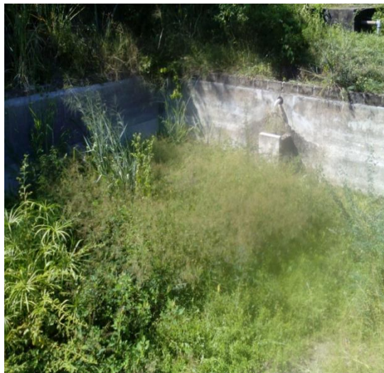
Figura 13. Estado actual del Filtro lento
