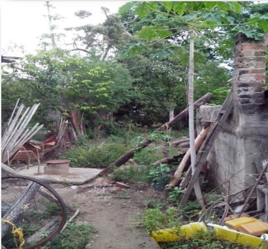
Fotografías 2, 3, 4, 5. Estado actual de los solares de las viviendas que pertenecerán a la Asociación Agrícola.
