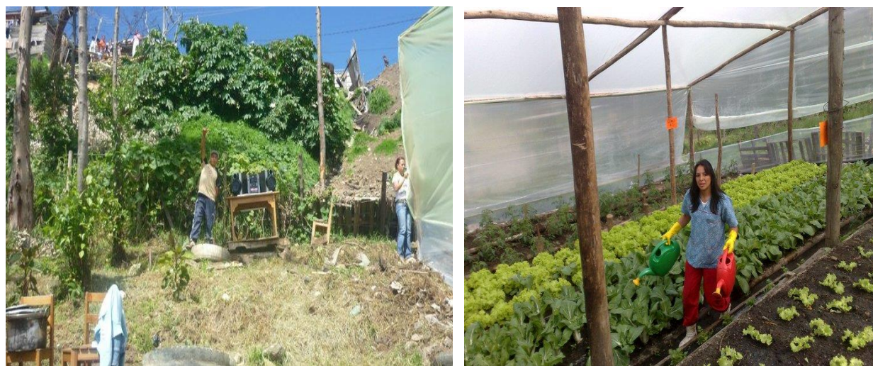
Figura 5.13. Antes y después de la construcción del invernadero
