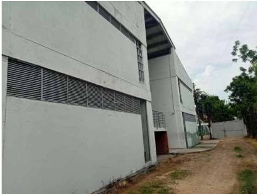
Imagen 4 – Vista de pórtico de fachada – Fuente: Autor
