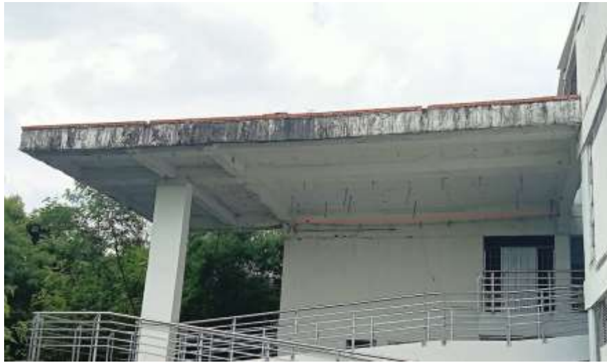
Imagen 9 – Vista deflexión placa de tanques – Fuente: Autor
