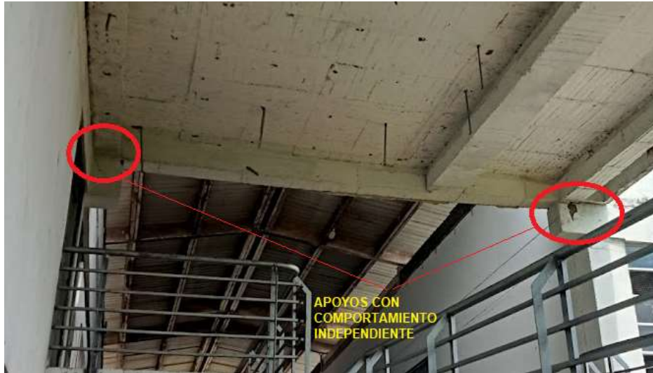
Imagen 12 – Vista de apoyo placa de tanque – Fuente: Autor
