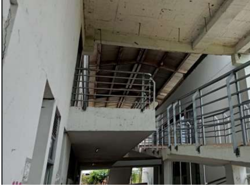
Imagen 5 - Vista de placa de piso—Fuente: Autor
