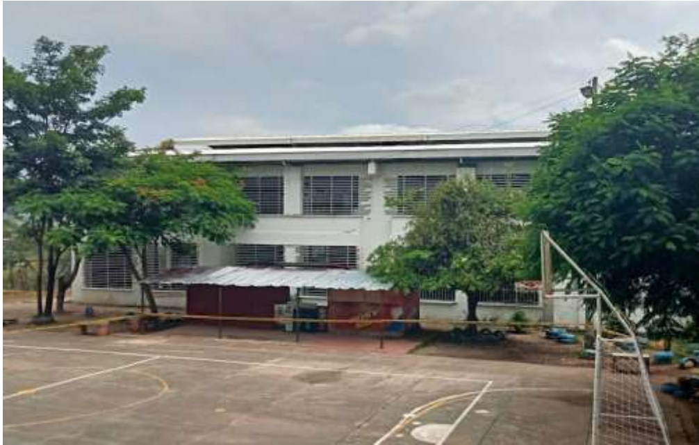
Imagen 3 – Vista general de la edificación – Fuente: Autor
