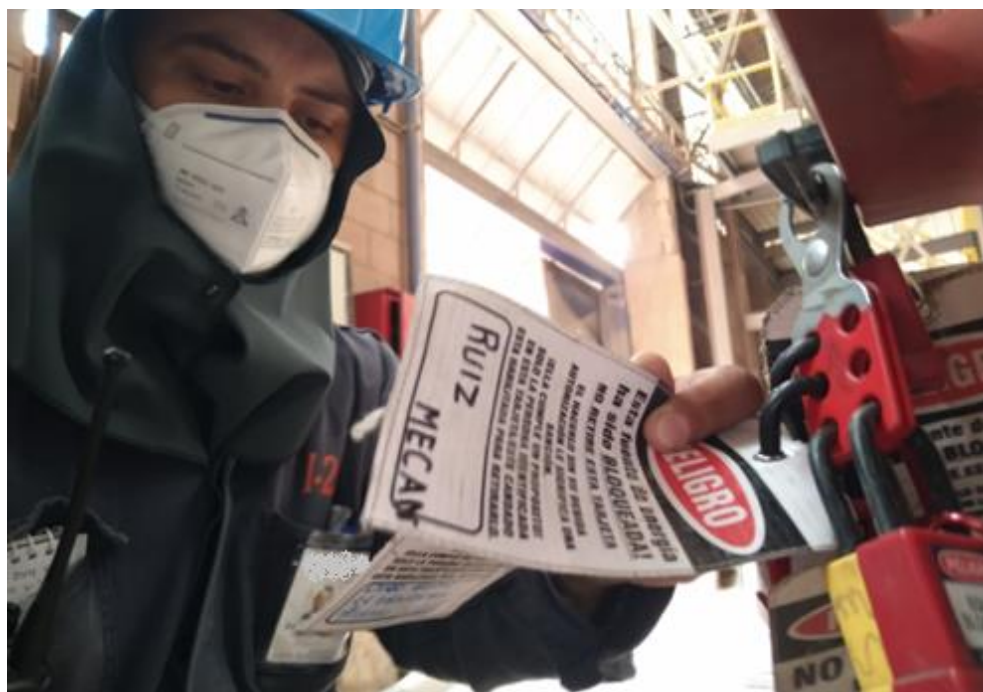
Ilustración 17 Inspección de Elementos de Bloqueo.
