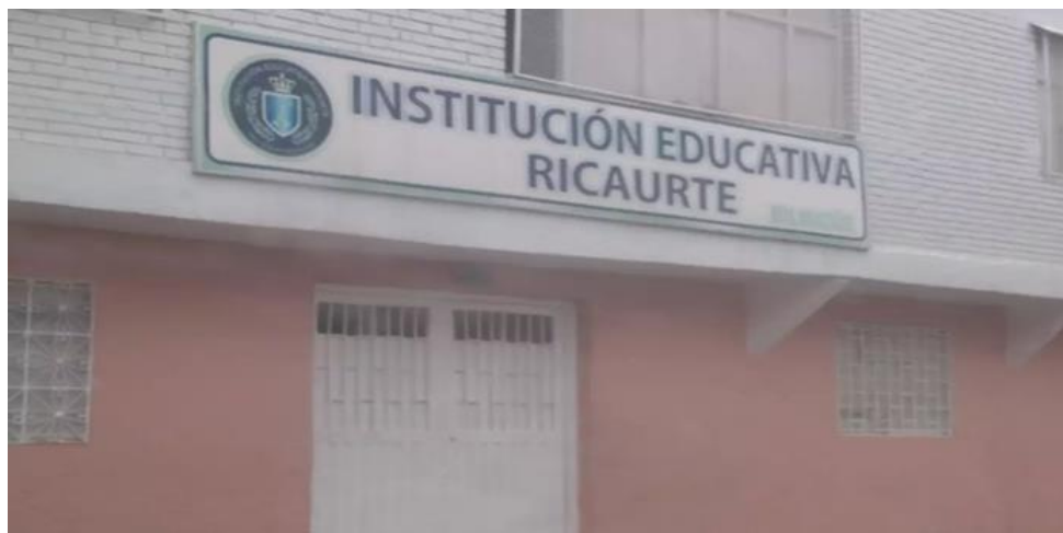
Figura 3. Fotografía de la fachada I.E Ricaurte – sede España
