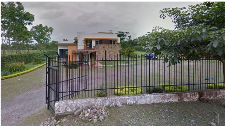
Figura 13 Instalaciones de la empresa
