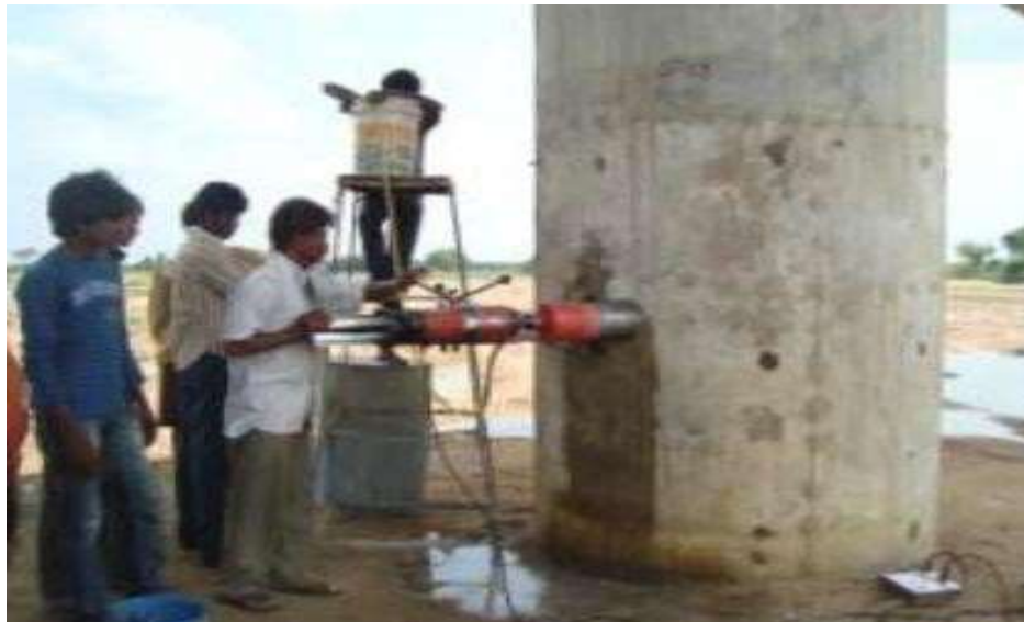
Figura 10. Extracción Del Núcleo De Hormigón Del Puente Pier
