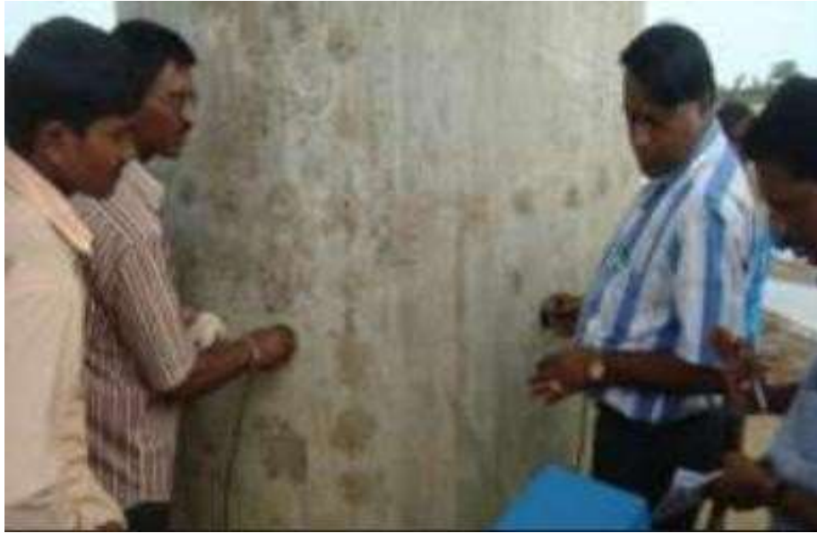
Figura 9. Prueba De Puente Pier Usando Ultrasonic Tester
