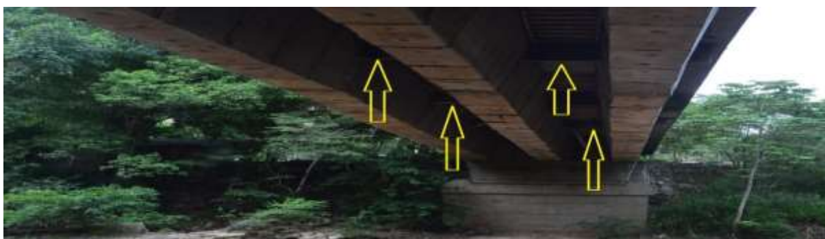
Figura. 39 Vista de Diafragma desde parte inferior de puente
