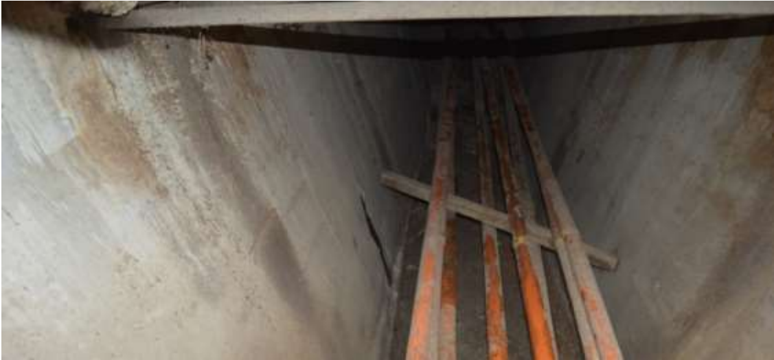
Figura .40 Cables de acero instalados en el interior de las vigas
