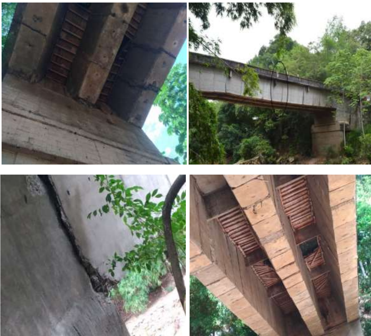
Figura 34. Estado de las Vigas (Dovelas)
