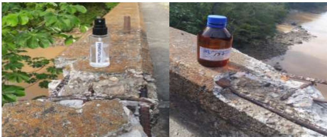
Figura. 41 Barandas del puente rociadas con Fenolftaleína
