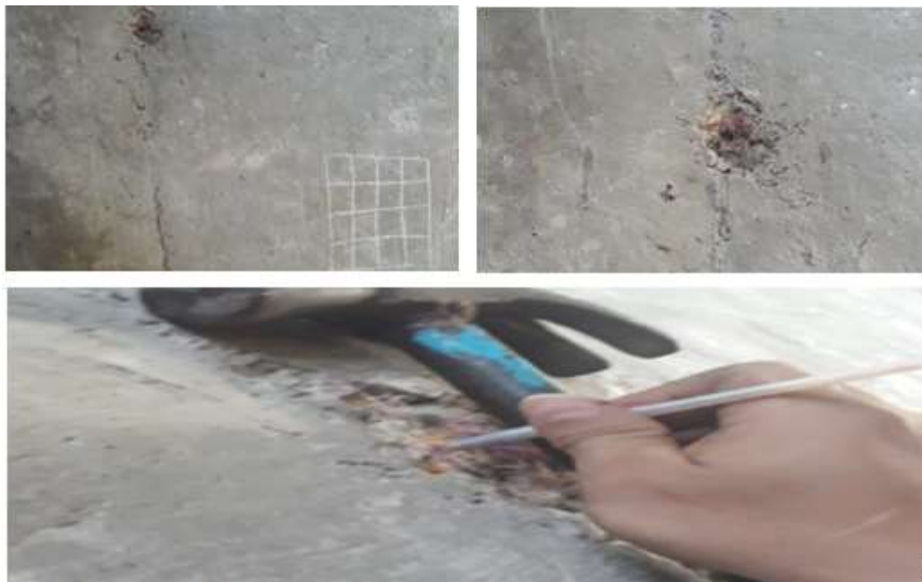
Figura .45 Parte de Macizo de Anclaje rociado con Fenolftaleína (Cañaverales)
