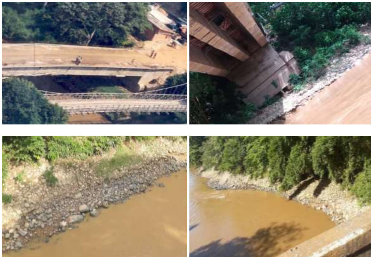
Figura 22. Protección A Taludes Laterales En La Base Del Punte
