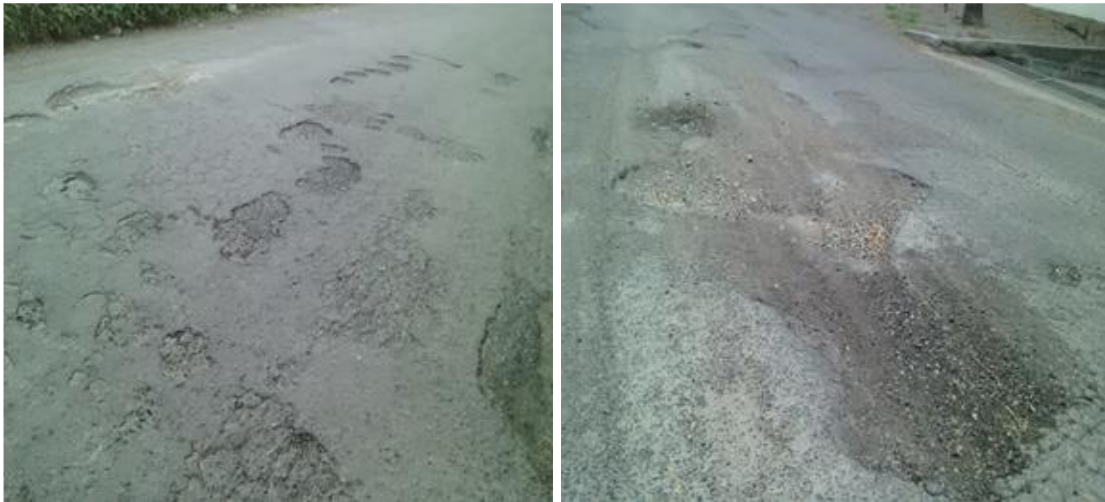
Figura 4. Estado actual del Tramo 2.
