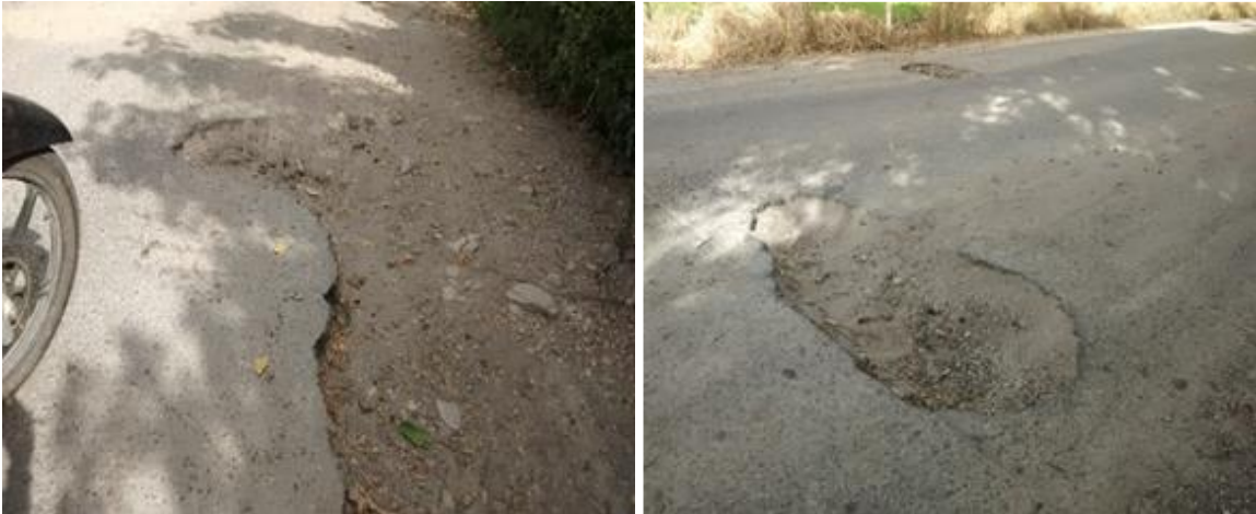
Figura 3. Estado actual del Tramo 1
