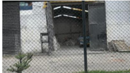
Fábrica de tubos PVC que produce ruido excesivo y esparcimiento de partículas al humedal.
