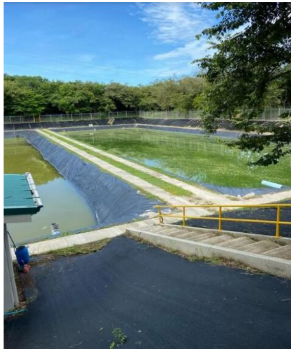
Imagen 10. En la Sede de Guanacaste se emplea tecnología de lagunas facultativas y se aplica cloración para reutilizar el agua en el riego de zonas verdes. (2024).
