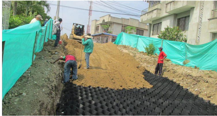
Figura 5. Colocación de geomallas o geosintéticos para estabilización de subrasantes en pavimentos
