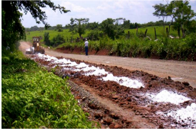
Figura 6. Suelo sometido a mejoramiento químico con cal
