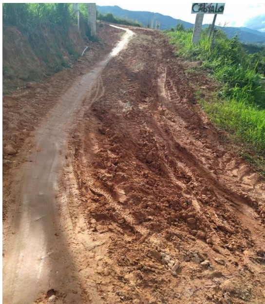
Figura 1. Vía sin pavimentar con suelo predominantemente arcilloso
