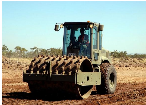
Figura 4. Compactación mecánica con rodillo pata de cabra de las capas de suelo de un pavimento
