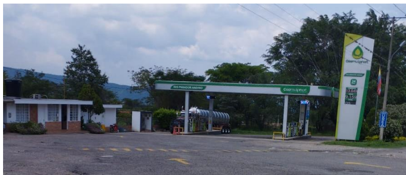
Ilustración 14 Instalaciones de la empresa Estacion de Servicio Parador Andino
