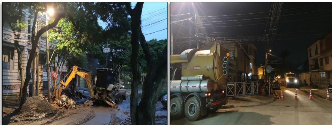
Figura 27: Limpieza de vías y sumideros
