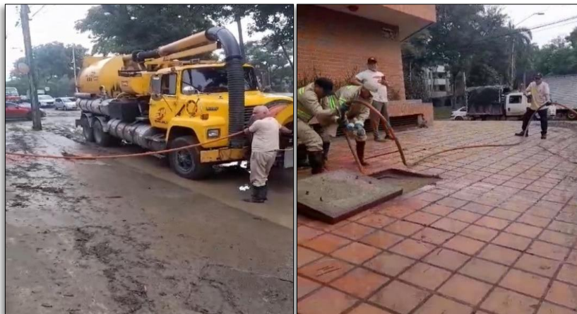
Figura 25: Limpieza de sumideros y cámaras de inspección
