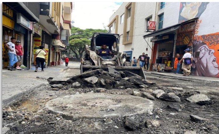
Figura 13: Remodelación de redes de alcantarillado
