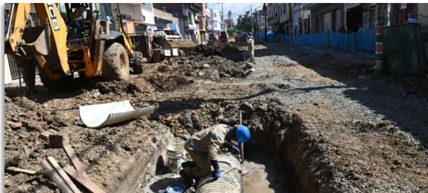
Figura 12: Reposición de redes de alcantarillado
