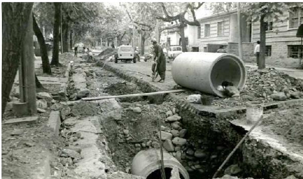
Figura 7: Ampliación Redes de Alcantarillado.
