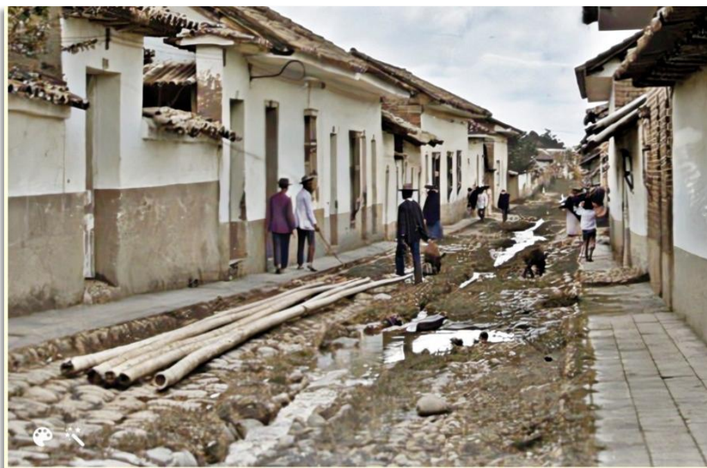
Figura 2: primeras acequias para evacuar aguas residuales por gravedad
