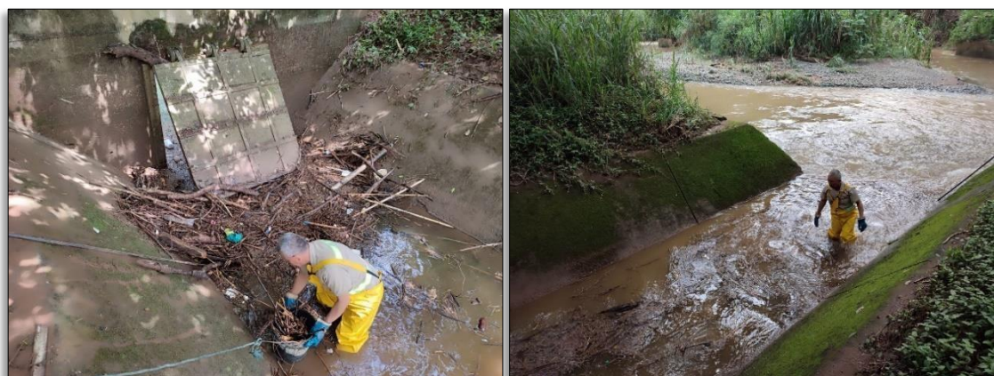
Figura 28: Limpieza de Chapaletas
