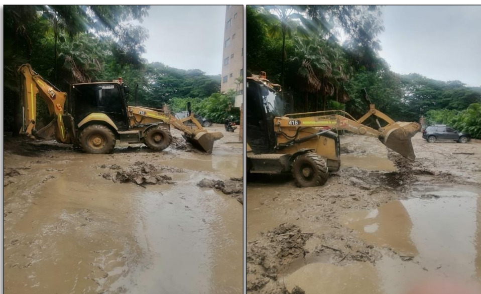
Figura 29: Limpieza de lodo y escombros
