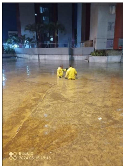
Figura 18 Limpieza de cámaras y sumideros
