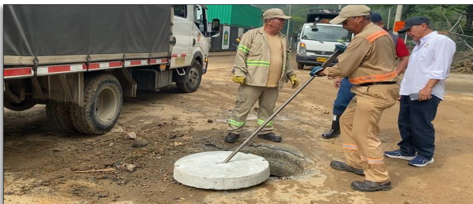
Figura 23: Reposición de tapas y rejillas averiadas
