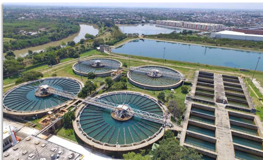
Figura 10: Planta PTAR Cañaveralejo
