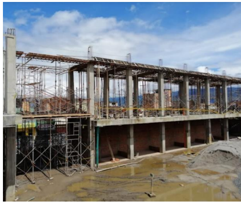
Ilustración 8 Edificación plaza de mercado
