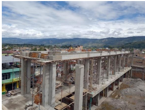
Ilustración 5 Estructura de concreto tipo aporticada
