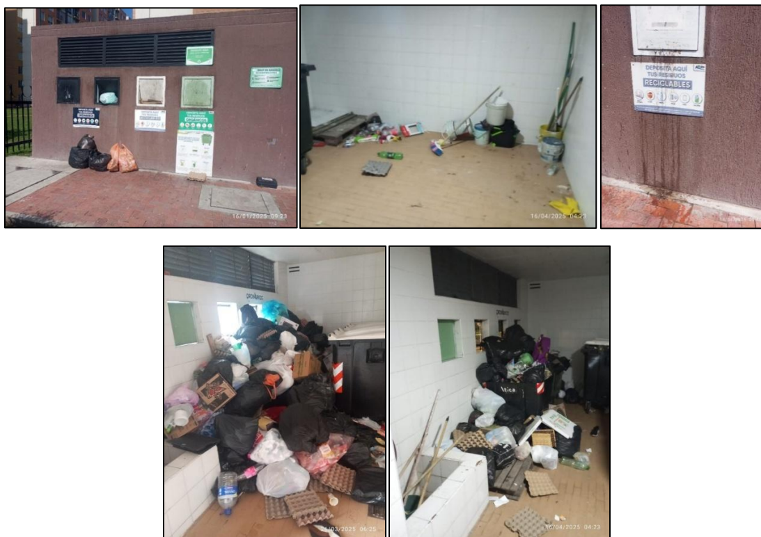
Imagen 19. Estado del shut antes de iniciar las adecuaciones propuestas en el proyecto
