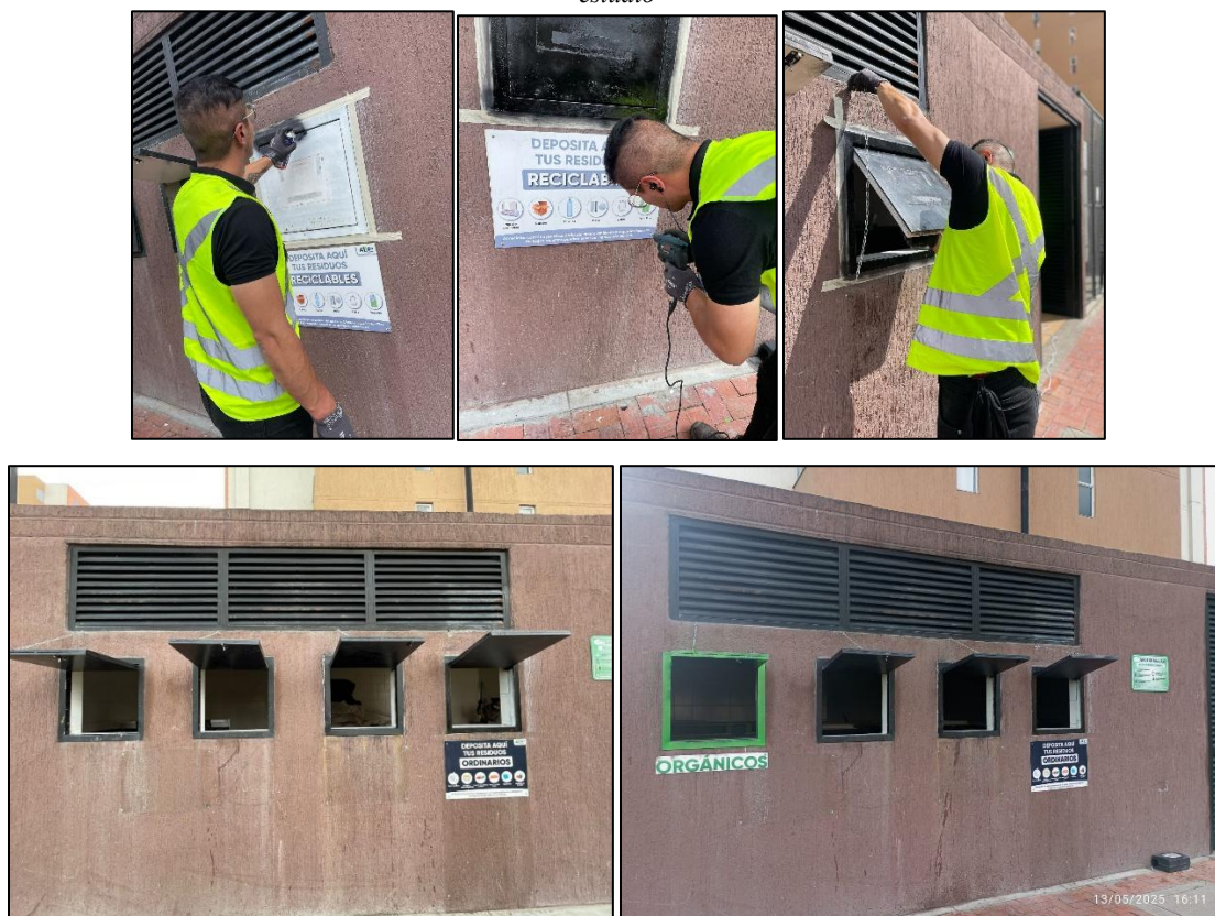
Imagen 59. Adecuación de ventanillas finalizando el ejercicio de disposición de residuos orgánicos selectivamente por grupos de estudio
