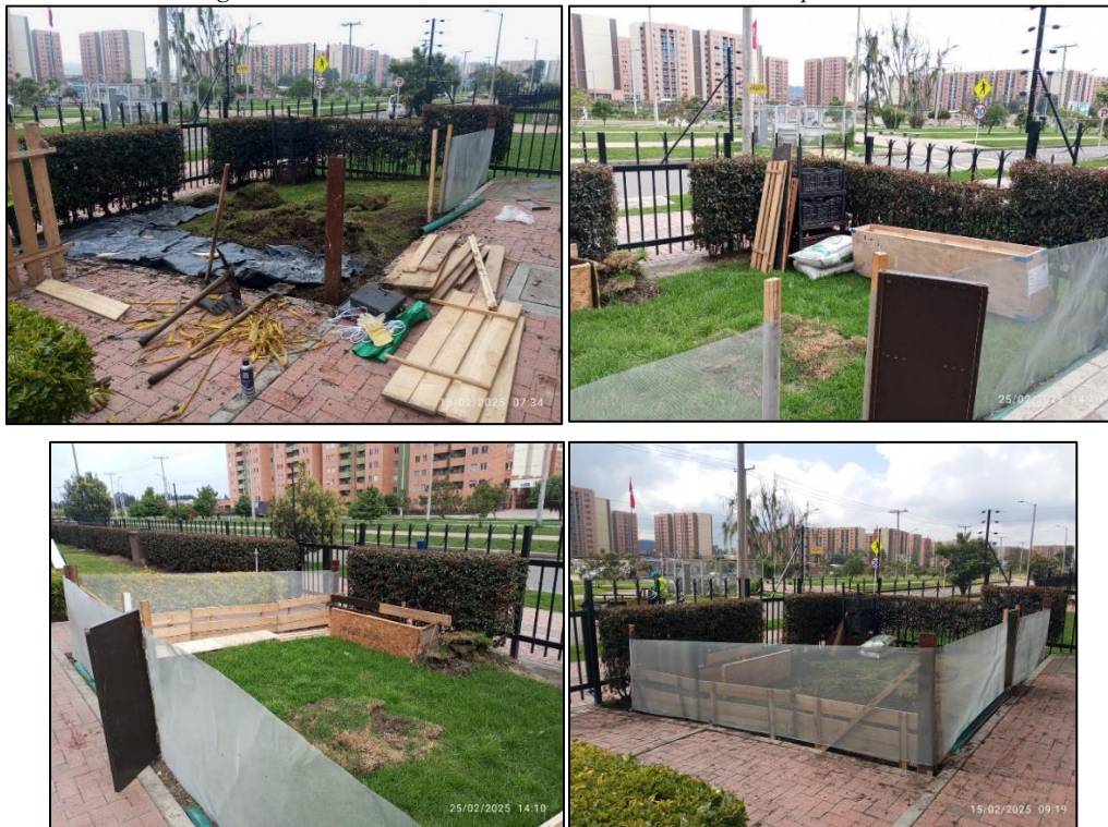
Imagen 34. Avances de la adecuación de la zona destinada para el vivero
