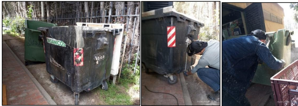
Imagen 22. Adecuación de contenedores utilizados como piloto para la adecuada separación de los residuos
