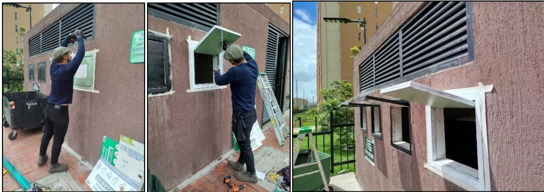
Imagen 20. Adecuación de ventanillas del shut
