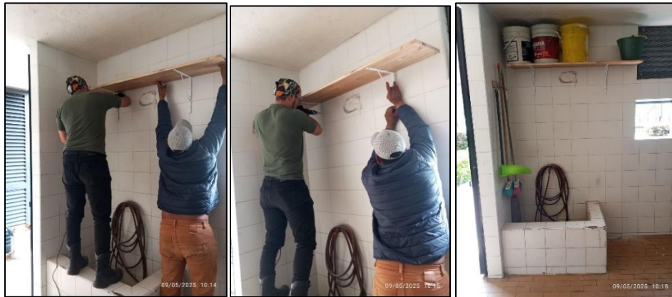
Imagen 63. Instalación de ordenador de elementos de aseo al interior del shut
