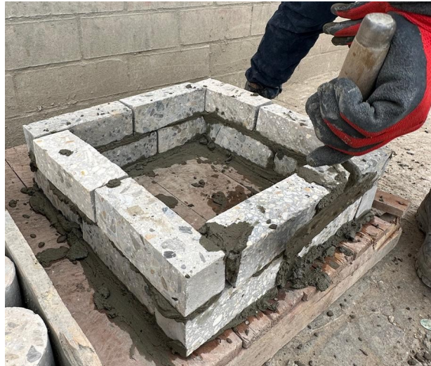
Figura 65. Paso 3: Emboquille de unidades para cajas de inspección
