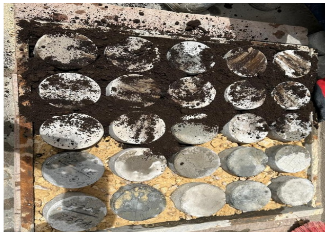
Figura 70. Paso 4: Emboquille de adoquín con tierra negra
