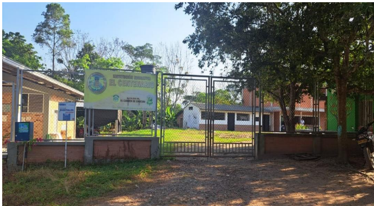
Figura 4 Institución Educativa El Centenario sede A. Fachada
