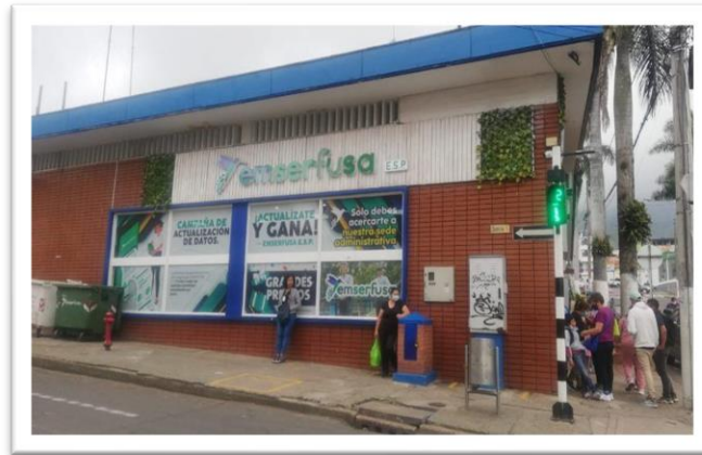
Figura 2. Entrada de la sede principal de EMSERFUSA. (2024)
