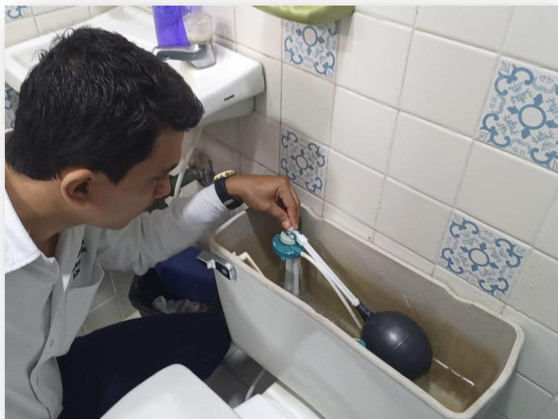
Inspección funcionamiento de válvulas sanitarios
