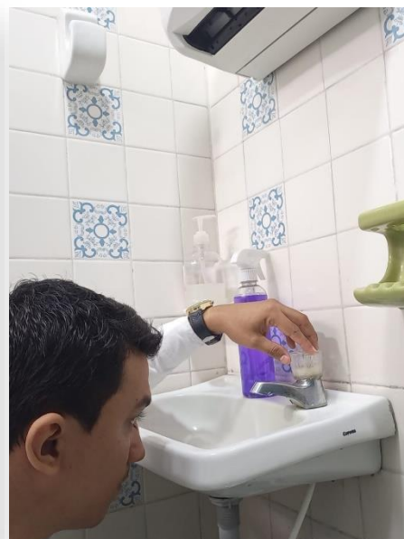
Inspección grifería lavamanos
